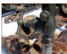
Sehr gut erhalten sind die 100 Jahre alten Gussrohre der Denzlinger Wasserleitung, wie sie im Unterdorf und in der Siedlung noch heute verlegt sind.
